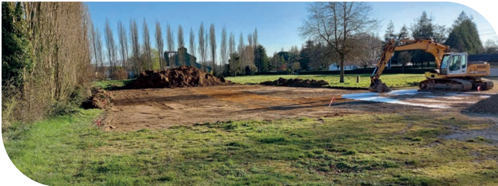
Lancement du CITY PARK situé dans la zone de loisirs 22.03.21
